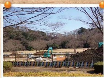
3月上旬の様子です。地面を掘った土の山があちこちに見え始め、遊具の基礎工事が本格的に始まりました。
