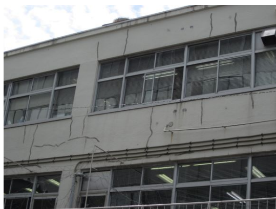
図6-2-4 本館外壁の状況
