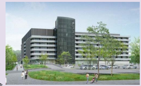
水戸市庁舎 (出典：国交省 防災拠点等となる建築物の機能継続に係る事例集)
