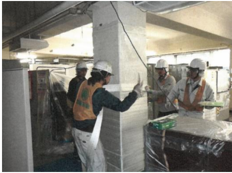
図 4-2-9 柱補強工事の状況
