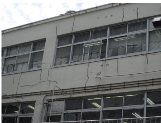
図6-2-4 本館外壁の状況
