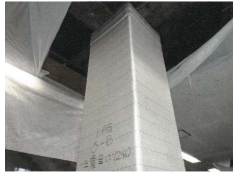
図 4-2-10 柱補強工事の状況
