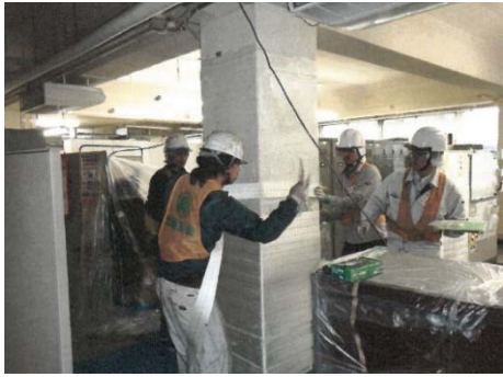
図 4-2-9 柱補強工事の状況
