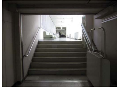
図 4-2-16 階段でつながる連絡通路
