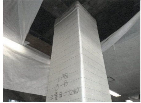
図 18 柱補強工事の状況
