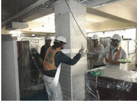
図 17 柱補強工事の状況
