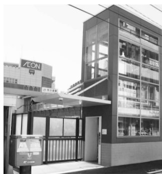
JR北小金駅北口エレベーター
