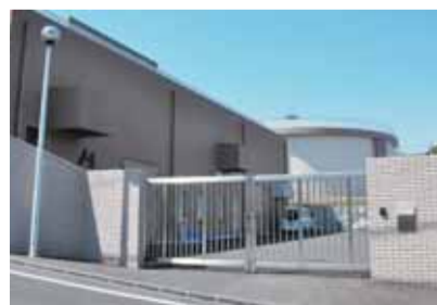
小金浄水場（二ツ木42の2） 大金平浄水場・幸田配水場と共に小金地区へ給水しています。
