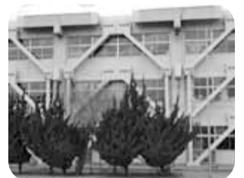
学校の耐震改修を計画的に実施します
