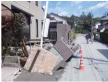
甚大な液状化被害を受けた街並み
