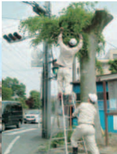
市民からの通報により、信号機に掛かった枝を危険と判断し、所有者の了解を得て剪定
