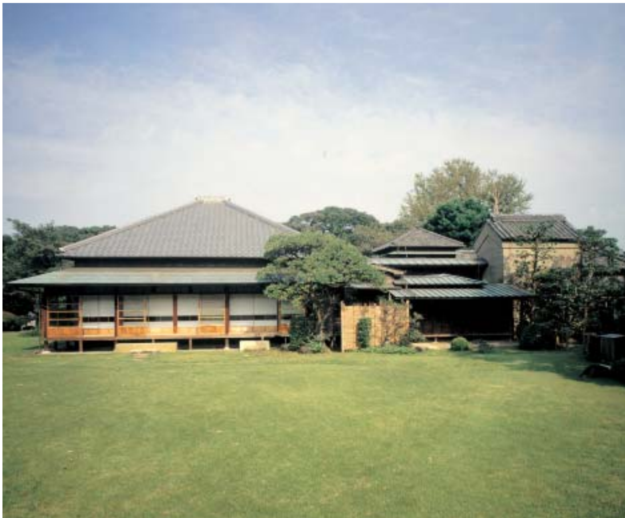
南側から見た戸定邸（左端が表座敷棟、右端が内蔵棟、その間の奥の屋根は台所棟2階）
