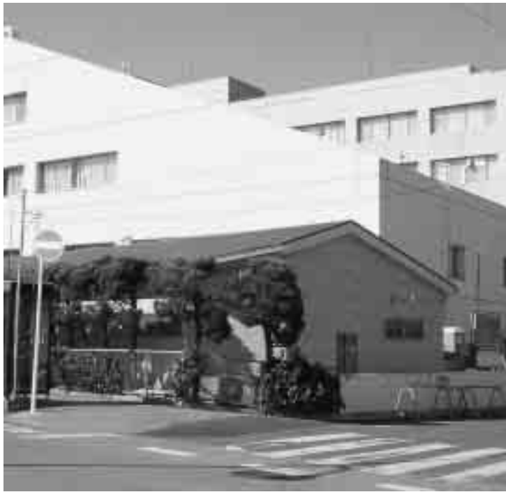
4月1日の開設に向けて、建築中の夜間小児急病センター (手前の平屋、2月13日現在)
