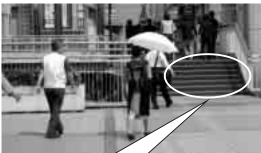
写真2 駅デッキと連絡通路の接続部分を見てみました
