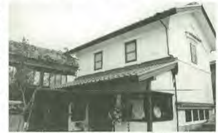
再生された明治中期の土蔵
