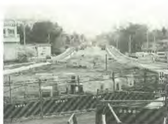
平成14年度開通(予定)に向けて工事の進む横須賀紙敷線
