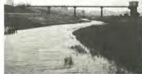
完成した流水保全水路
