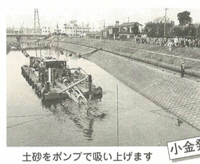
土砂をポンプで吸い上げます
