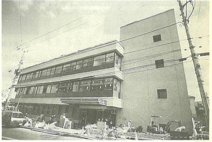
完成間近な中央保健センター
