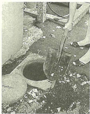
排水マスの清掃
