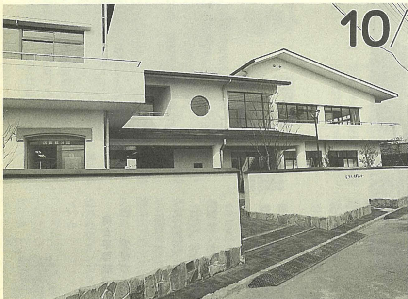
完成間近かな八ヶ崎市民センター
