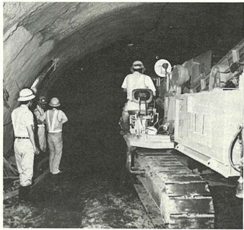
国分川分水路工事
