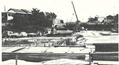
水上勉の家は現在北総鉄道の工事現場に
