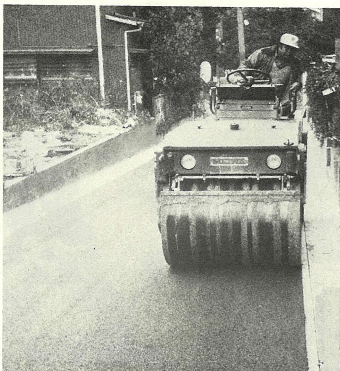
私道を舗装して安全で使いやすい道路に
