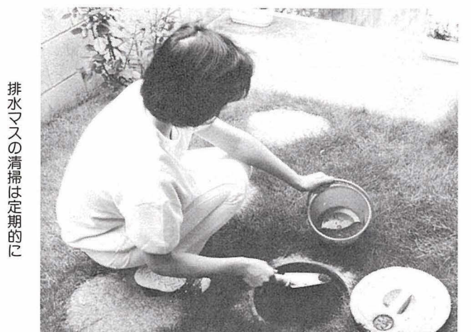
排水マスの清掃は定期的に行う
