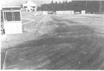
消防訓練センターの建設工事
