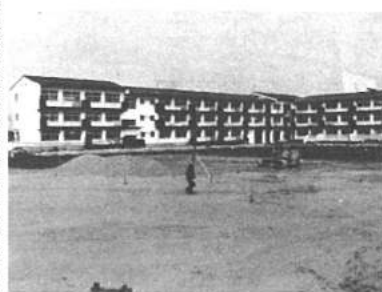
建設中の新松戸西小学校
