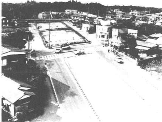
立体交差工事が始まる3-3-7号
