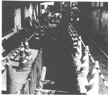
下水道管布設工事(三矢小台地区)
