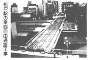
松戸駅の東西自由通路工事
