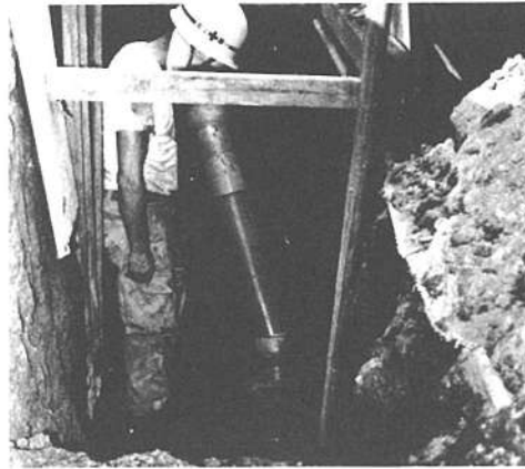
下水道本管と家庭からの排水管をつなぐ工事
