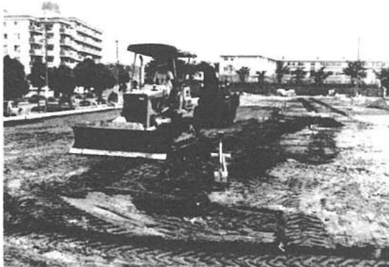
7月オープンをめざして工事が進む中央ゲートボール場
