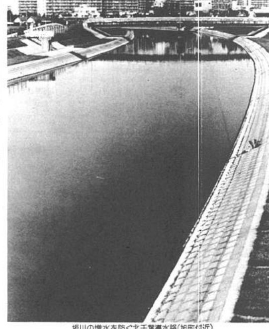
坂川の増水を防ぐ千葉導水路(旭町付近)
