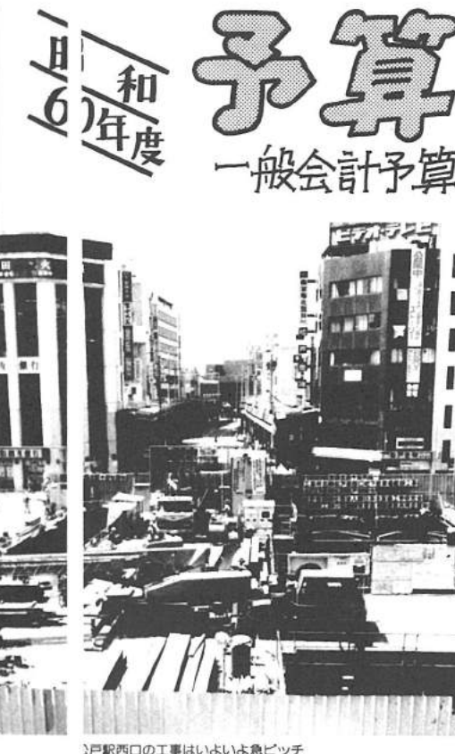
2月6日 松戸駅周辺の工事はいよいよ急ピッチ
