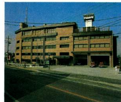
消防体制の中枢・消防局の庁舎を58年1月、完成させました。最新の通風施設が整備されています。
