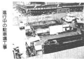
進行中の駐車場工事
