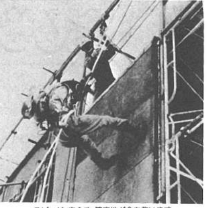
スピード・安全性・確実性が命を救います
