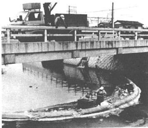
市では、主要河川のごみを定期的に取り除いています(新坂川で)
