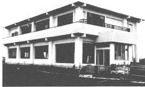
建物も完成し、開所を待つばかりです
