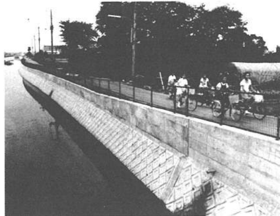
護岸工事は着々と進んでいます(坂川橋付近)
