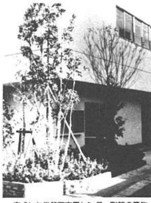
完成した常盤平市民センター別館の建物
