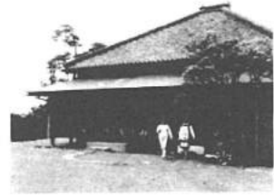
改修工事前の戸定館
