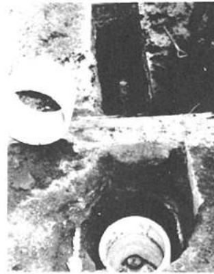
家庭からの汚水管を枝管へ接続
