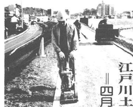
工事も着々と進んでいます
