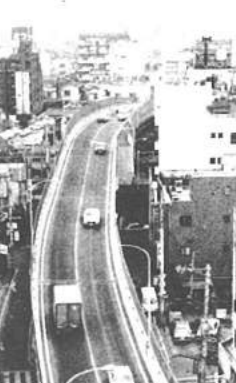
常磐線による東西の分断解消へと、昭和52年から国鉄と協力し、工事を進めていた若岩線橋が完成しました。
