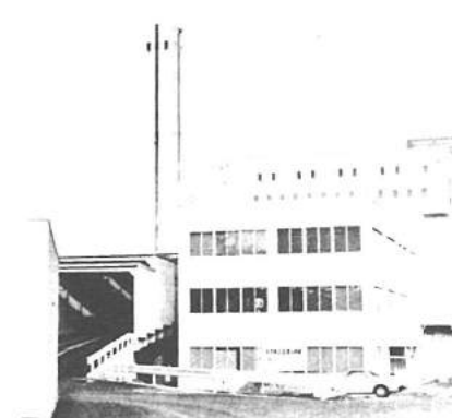
年々増加するゴミに対処するため、昭和53年から建設していたクリーンセンターが地元協力を得て完成しました。公害防止には細心の注意を払っています。
