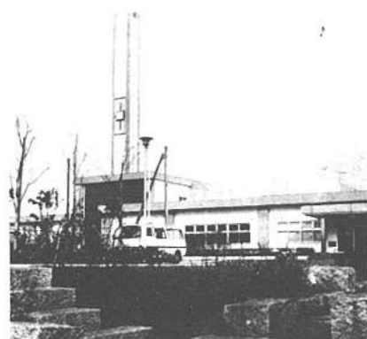
各家庭から出る尿に対処するための処理施設、東部クリーンセンターが完成。処理能力は1日300t。公害防止には細心の注意を払っています。
