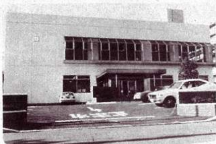
六実支所(市民センター・図書館分館も併設)が7月完成。
