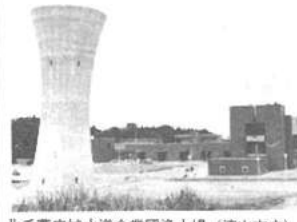
北千葉広域水道企業団浄水場(流山市内)
