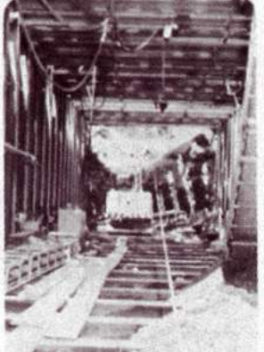
東西の分断解消へあと一歩…松戸駅南側(市民会館わき)地下道が貫通(今春開通予定)
