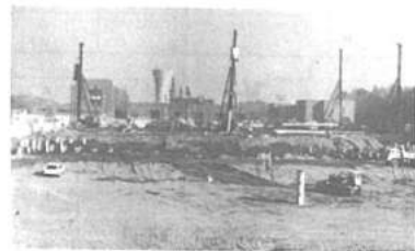
流山市にある北千葉広域水道企業団浄水場
