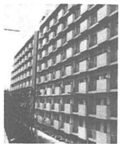
幸田第2市営住宅を建設
