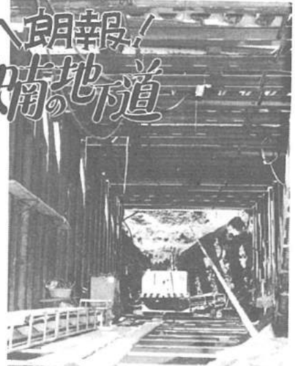
急ピッチで、工事が進められている松戸駅南側地下道工事
