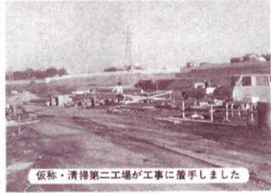
仮称・清掃第二工場が工事に着手しました
