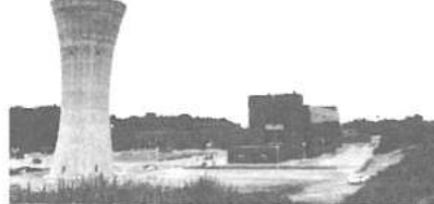
通水を開始した北千葉広域水道企業団浄水場(所在地 流山)
