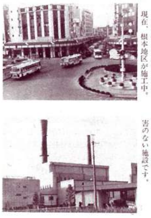
再開発事業：松戸市の玄関口に見合う街づくりを—と松戸駅西口地区が完成、現在、根本地区が施工中。
