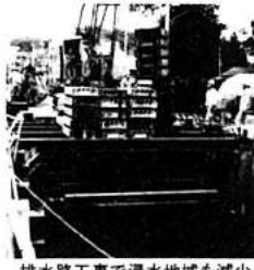
排水路工事で浸水地域も減少
