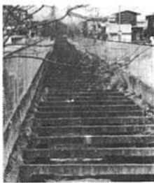
完成した富士川排水路
