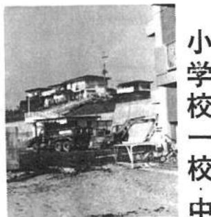
始まった野原中学校の増築工事
