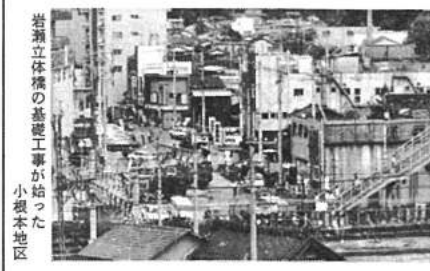
岩瀬立体橋の基礎工事が始まった 小根本地区
