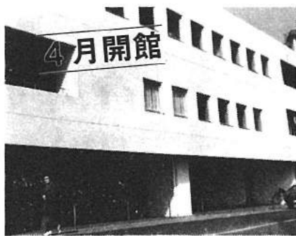
近くオープン予定の衛生会館
