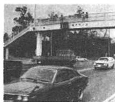
このほど、千葉大園芸学部正門前の国道6号線に、横断歩道橋が完成しました。ご利用ください。
