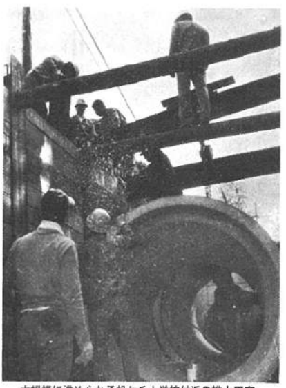
大規模に進められる松ヶ丘小學校付近の排水工事
