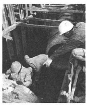
六間川へ結ぶ排水工事(古ヶ崎赤橋付近)
