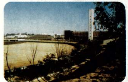
左・清掃工場…七右衛門新田316☎41-6151番…市内のごみを一手に引き上げ、2つの焼却炉と日本初のごみ粉砕機、最新鋭の流動焼却炉で処理しています。 左下・常盤平衛生処理場…常盤平松葉町1-3☎87-5650番…全市のし尿と常盤平団地の汚水を処理しています。 下・ユウカリ交通公園…小金原団地1号公園☎41-2707番…楽しく遊びながら交通ルールを学べる公園です。 右・運動公園…上本郷第2次土地区画整理地内☎63-9241番総合運動公園としてすでに管理棟、武道館、プール、野球場が完成しており体育館もまもなく完成します。 右下・栗ヶ沢公園庭球場…小金原8-26☎42-0945番…10面のコートをもつマンモス庭球場。
