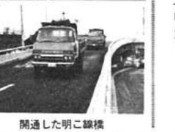
開通した明二線橋
