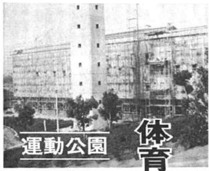
運動公園 工事をいそぐ体育館
