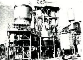
プラスチックゴミも退治する流動焼却炉
