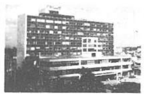
5月末、10階建ての市庁舎新館が完成
