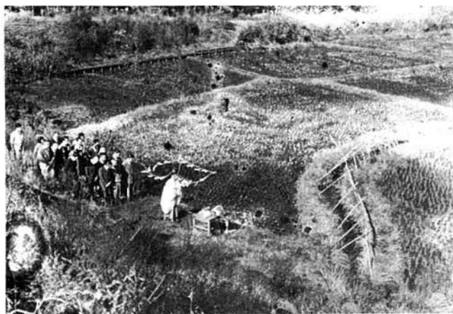
◇常盤平団地起工式（昭和30年）…金ヶ作地区土地区画整理起工式。当時東洋一といわれた大規模団地の造成がスタート。
