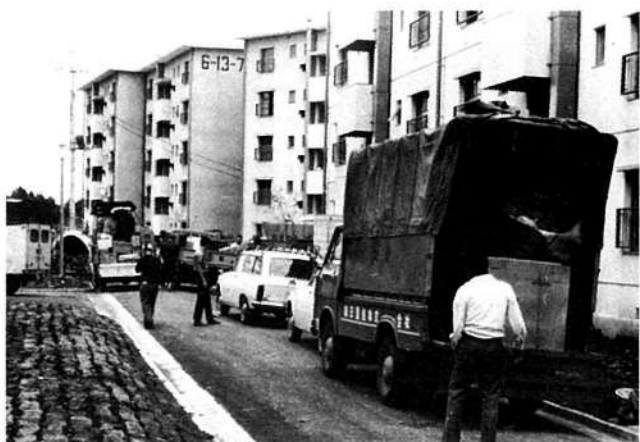
◇小金原団地入居開始（昭和44年）…常盤平団地以上の規模をもつ小金原団地が完成、入居が開始されました。
