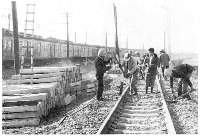
◇進む常磐線複々線化工事（昭和46年）…国鉄の輸送量増強のための複々線化工事が進められ47年に千代田線が開通しました。
