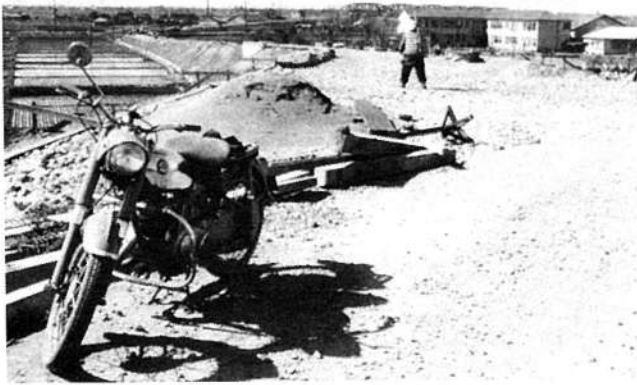
◇道路改修工事（昭和33年）…南部小前の道路改修工事。
