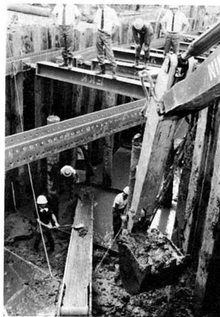
◇着々進む下水道工事（昭和49年）…各地区で下水、排水工事が急ピッチで進められています。
