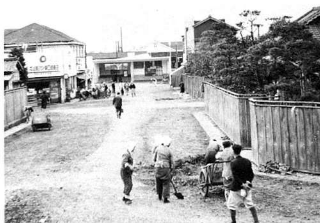
◇舗装工事（昭和30年）…進む土木事業、市街地の造成を合言葉に各地で道路舗装や下水工事が進みます。＝松戸駅東口＝
