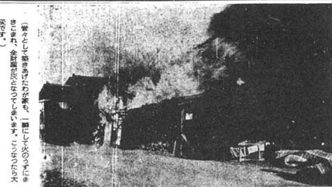
「燃やして焼きあげたのが家も、一瞬にしてのうすすまきまされ、金財難がたつてしまします。こんなった大災害です。」
