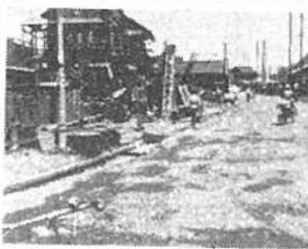
(写真は、松戸驛西口改修工事)
