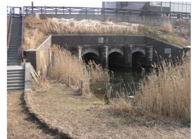
【柳原水閘】 1904年に作られたレンガ造りの水門で、土木遺産に認定されています。
