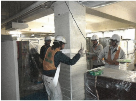
図 4-2-9 柱補強工事の状況
