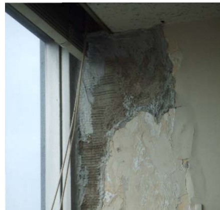
図 4-2-6 内壁の損傷
