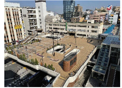
■松戸駅西口デッキの整備
