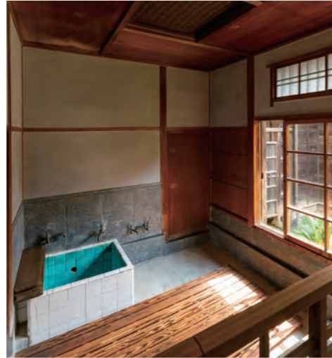
▲湯殿 浴槽は、昭和初期のものと考えられる。洗い場が広く天井も網代編みの意匠の質沢な造りとなっている。
